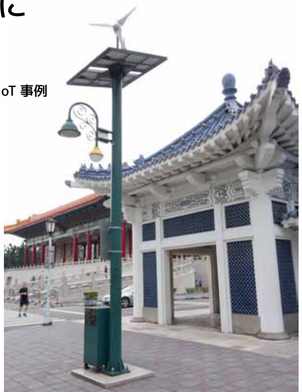
風力タービンと太陽光パネル(上部)による完全独立型電源システム
