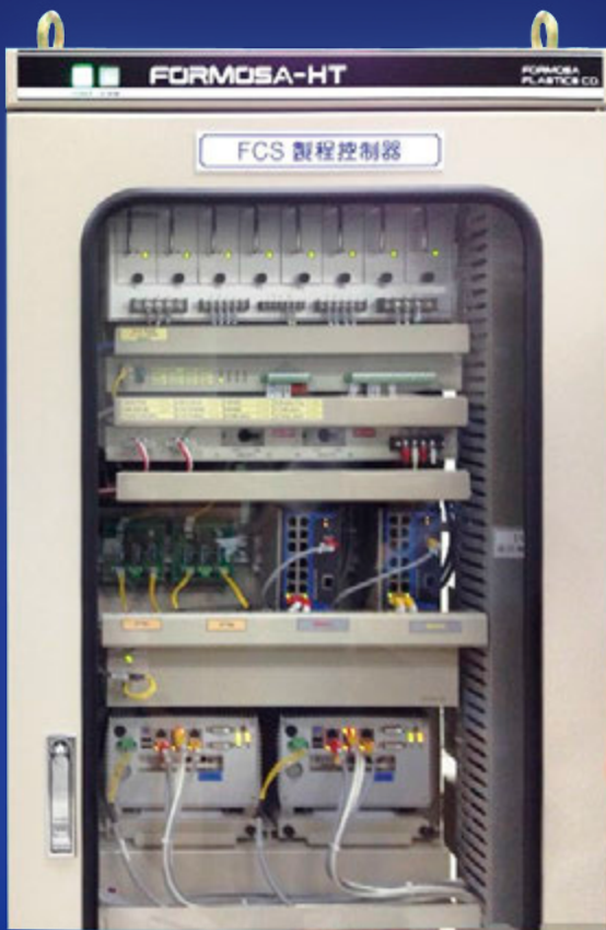
图 2. FORMOSA-FX* 系统使用新汉 NISE* 3660 作为 DCS 控制器
